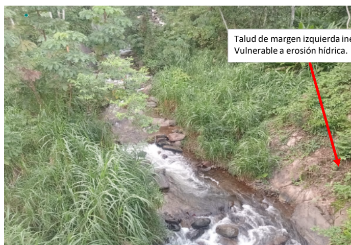
FIGURA N°02: VISTA DEL CAUCE DEL RÍO QUISTO, TALUD DE LA MARGEN IZQUIERDA INESTABLE. EXPUESTO A EROSIÓN HÍDRICA DEJANDO VULNERABLE LAS ÁREAS ADYACENTES DONDE SE UBICAN LAS VIVIENDAS DEL SECTOR NUEVO PARAÍSO.
