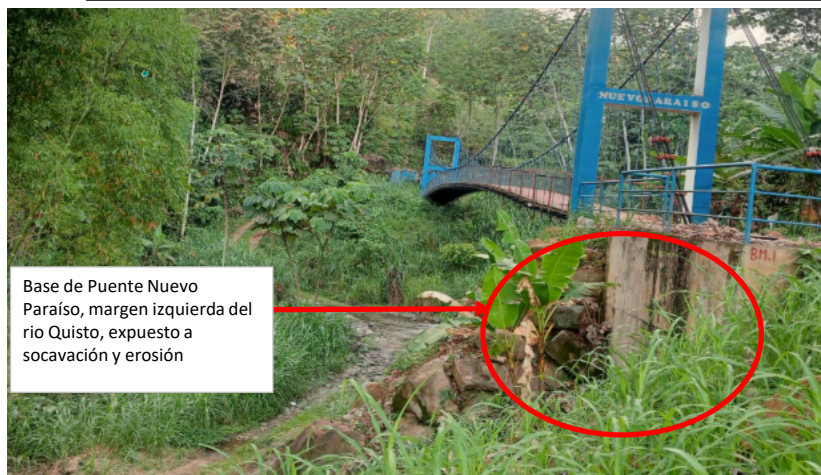
FIGURA N°04: VISTA DEL PUENTE NUEVO PARAÍSO (ÚNICA VÍA DE CONEXIÓN ENTRE COMUNIDADES) EXPUESTO A SOCACACIÓN DE BASE DE LA MARGEN IZQUIERDA, POR EFECTO DE LA CRECIDA DEL RÍO QUISTO.
